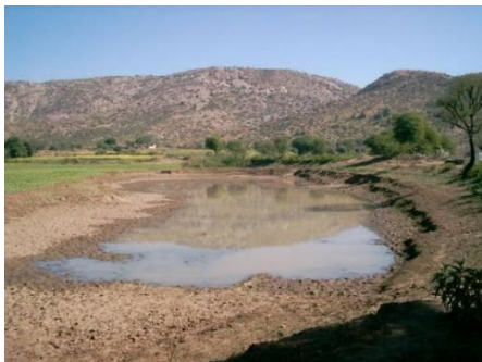
Des centaines de «johads», terme local pour désigner les réservoirs d'eau en terre
